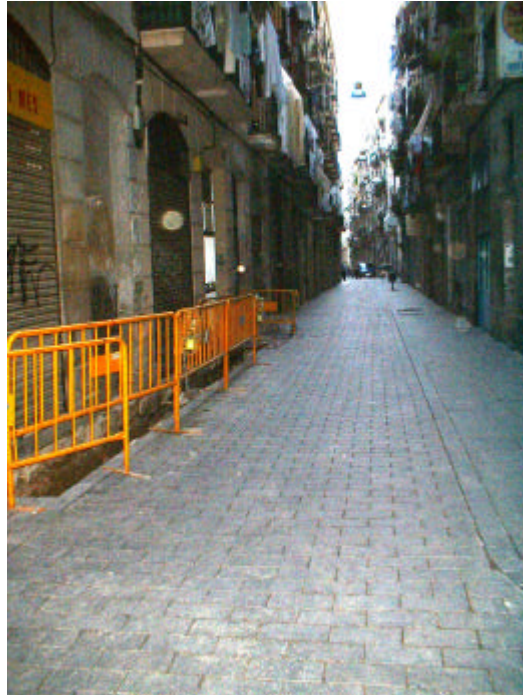
FOTOGRAFIA 1: Vista general del Carrer del Lleó.
