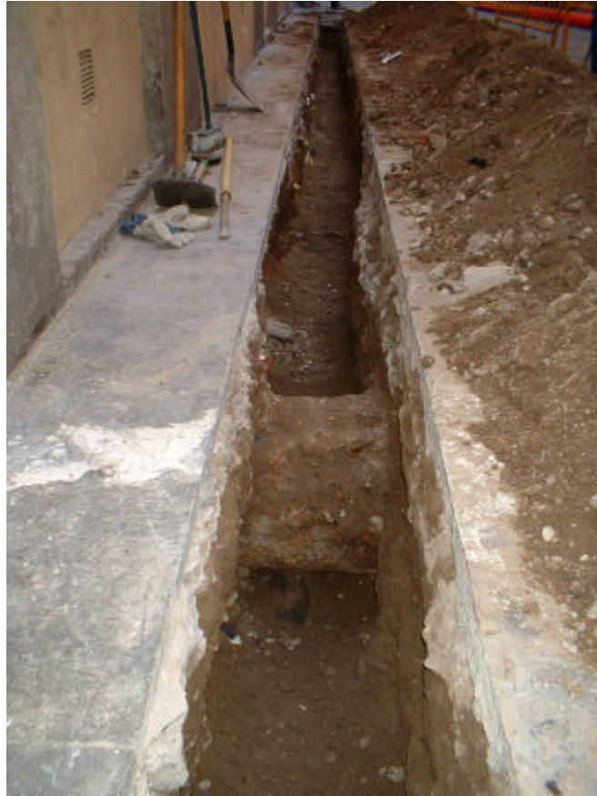
FOTOGRAFIA 5: Vista general de la Rasa 200
