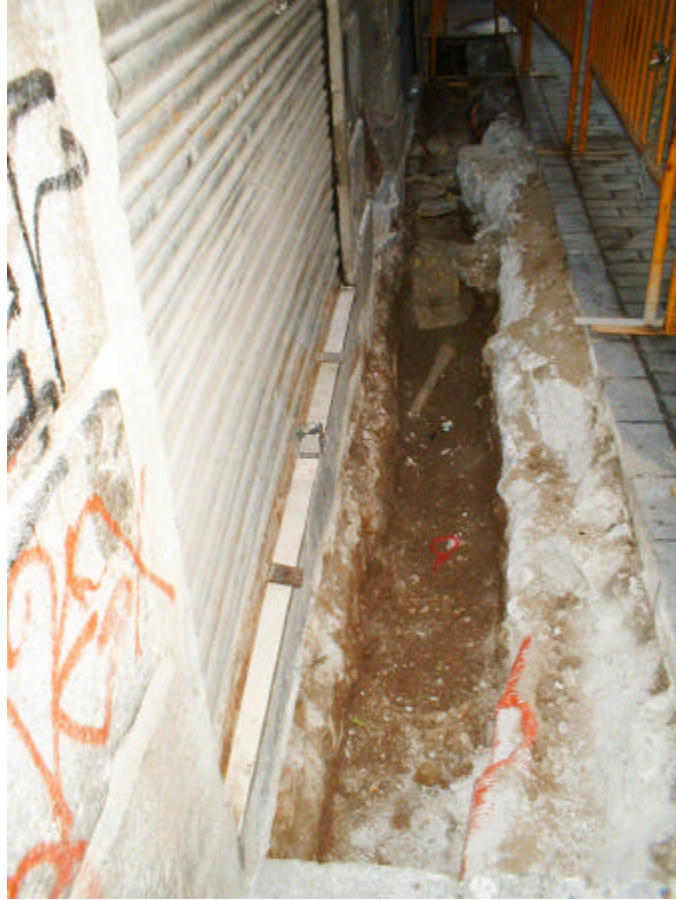
FOTOGRAFIA 3: Vista general de la Rasa 100.
